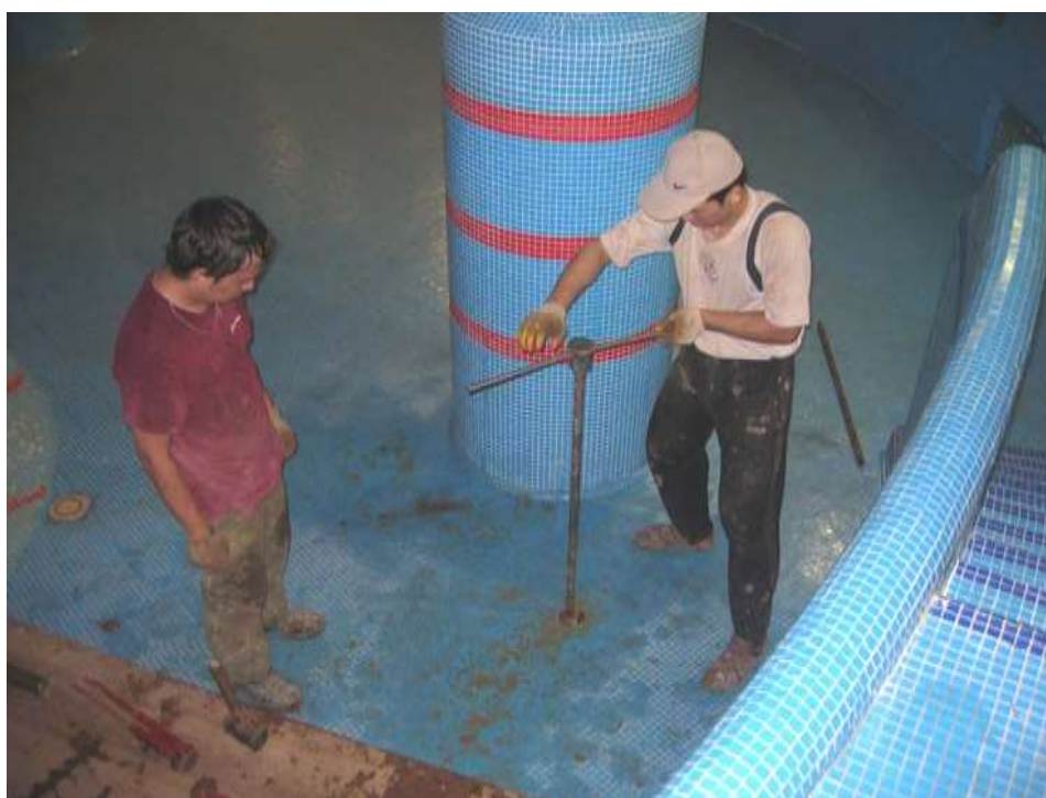
Фото 14. Бурение скважины С-7 вручную с уровня дна бассейна.
