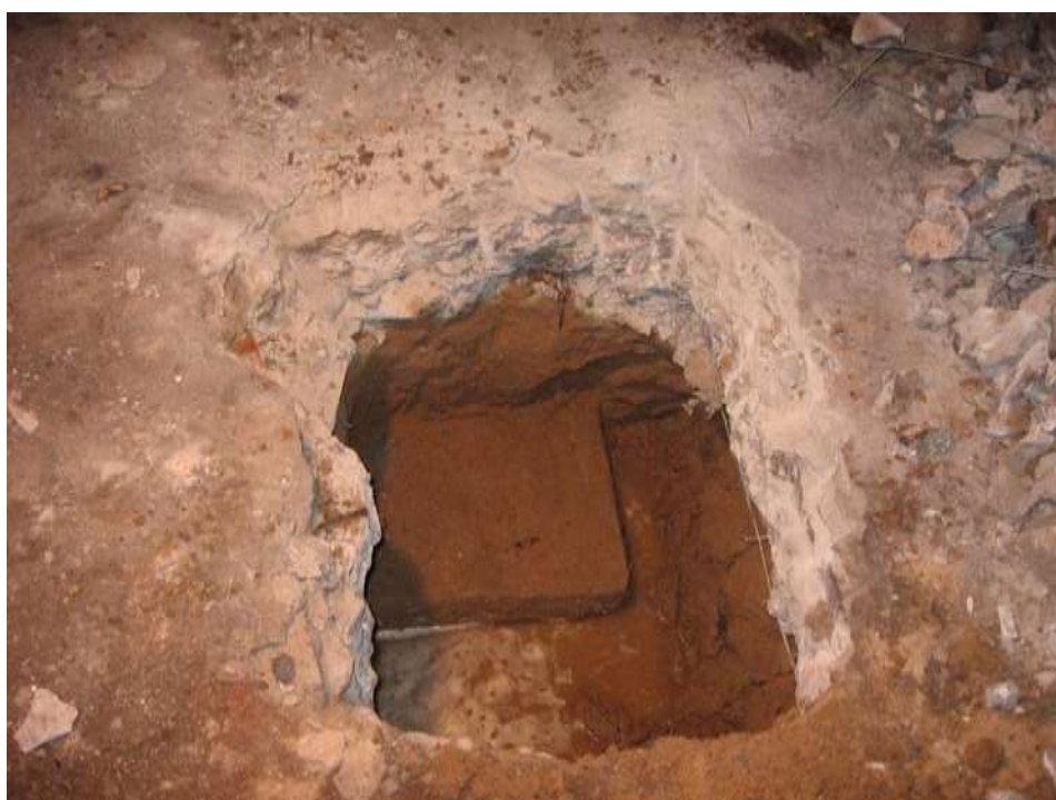
Фото 12. Вид подколонтник из монолитного бетона в шурфе № 4.
